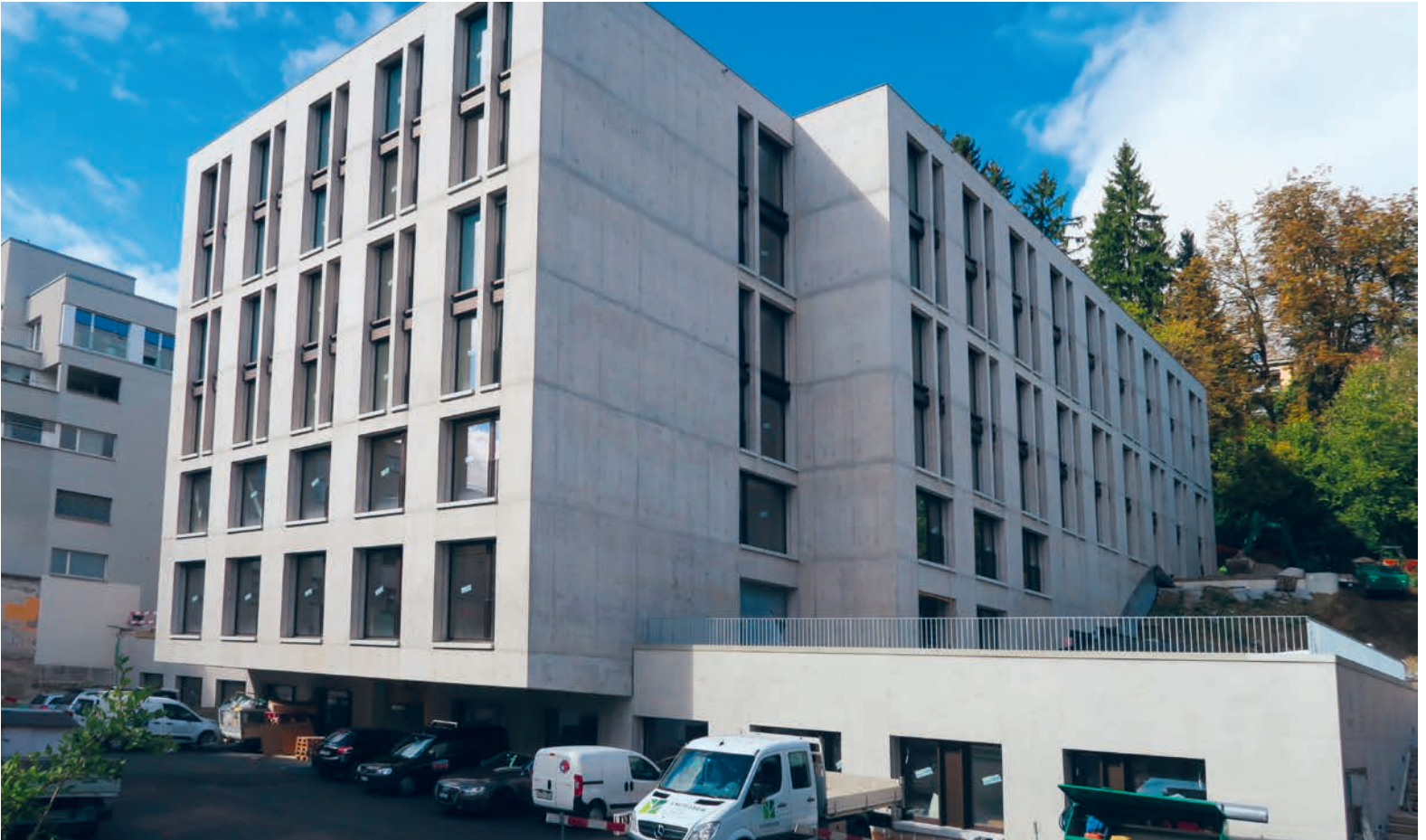
Das Marthaheim und das Josefshaus werden per Januar 2020 zur GHG Rosenberg zusammengeführt. Das bestehende Gebäude heisst «Haus Lachen», das neue Gebäude «Haus Röteli».
